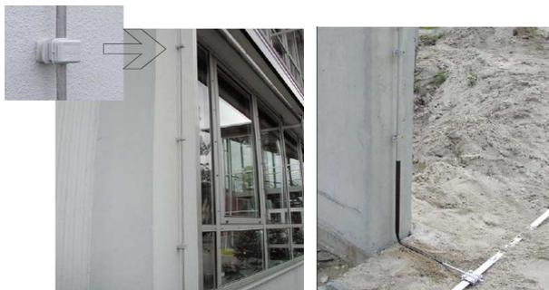
**3.8.9 Instalación de tierra.** A través de ella la corriente del rayo se dispersa en el terreno. Para su realización se utilizan diferentes sistemas: tomas de tierra de cimientos, tomas de tierra superficiales o tomas de tierra de profundidad.
