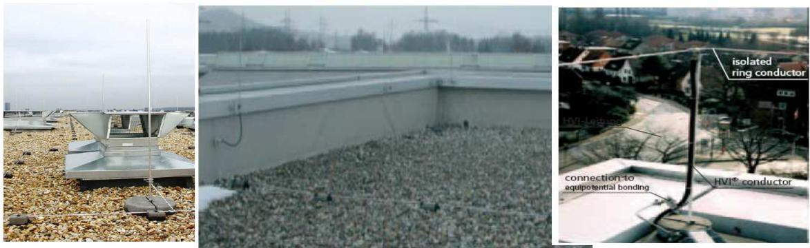
**3.8.8.4 Bajantes y derivaciones.** El objetivo de los bajantes es derivar la corriente del rayo que incide sobre la estructura e impacta en los elementos de interceptación.
